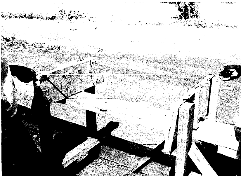
Fig.62 Cette mesure doit être la même à 2 mm près lorsque faite aux deux autres coins des planches
