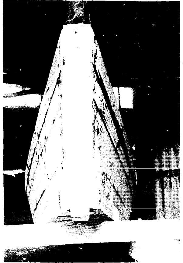
Fig.183 Autre vue de la lisse d'étrave avec le haut fini et le trou d'amarrage percé. Noter le recouvrement des bouts de la quille et des lisses de bouchain
