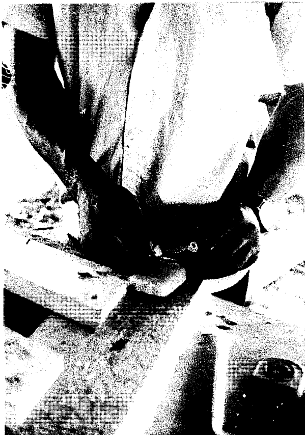
Fig.75 Frotter le filetage des vis avec du savon pour faciliter le vissage Fig.75 Rub screw threads with soap for easy screwing
