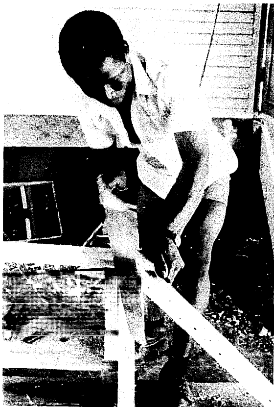
Fig.91 On scie les bouts dépassant des porte-étraves
