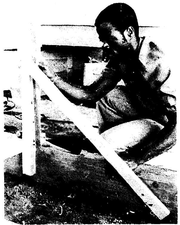
Fig.45 Afin que les montants soient d'équerre avec les longerons, vérifier avec une grande équerre de maçon
