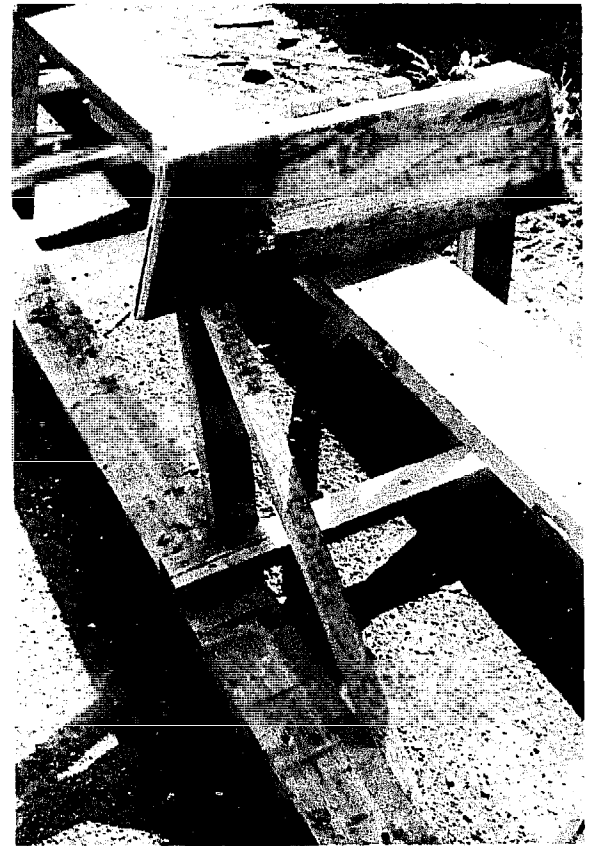
Fig.63 Si cette mesure n'est pas la même dans les deux sens, on devra pousser ou tirer sur les planches jusqu'à ce que les deux mesures en X soient pareilles. On tient alors les planches en position avec des arc-boutants
