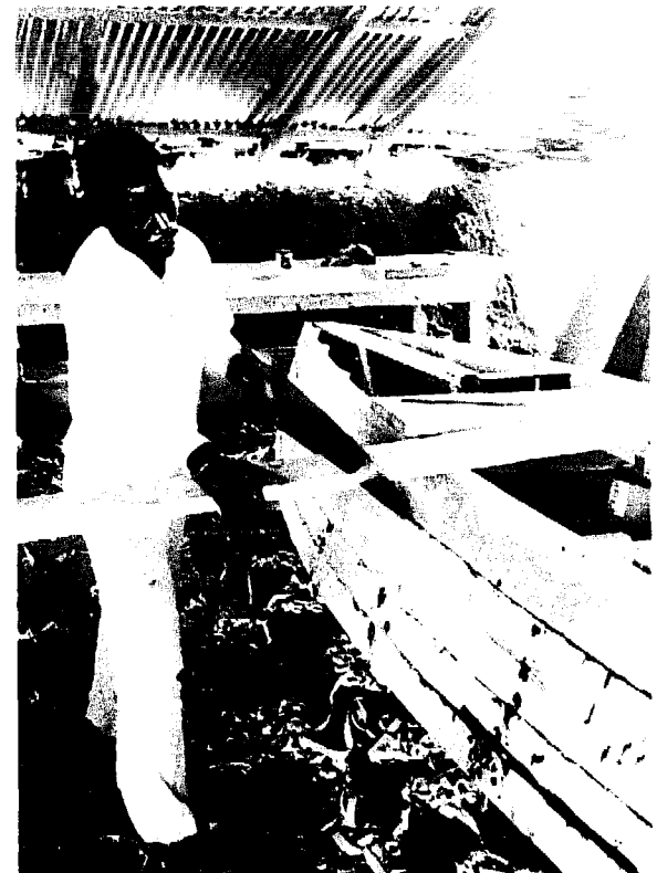
Fig.157 Retourner la planche et scier en dehors du trait en s'appuyant sur le fond du bateau Fig.157 Turn the plank over and cut outside of the line, leaning the plank against the bottom of the canoe
