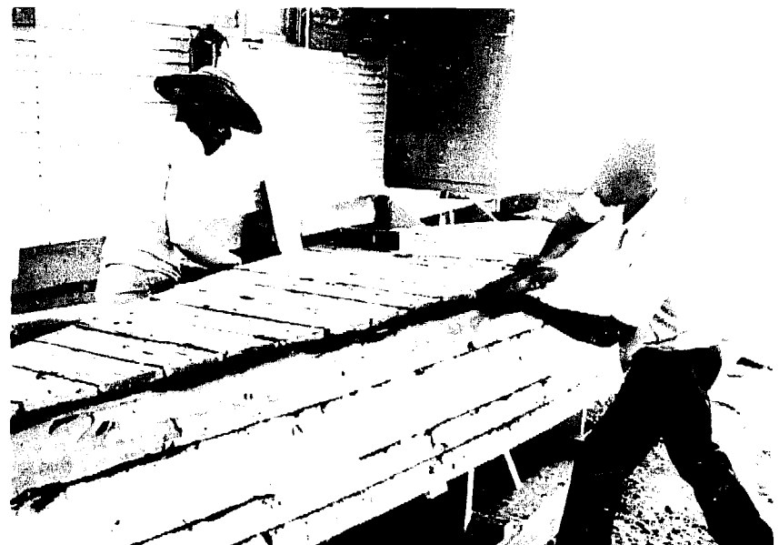
Fig.168 Raboter le bout des planches de fond à égalité avec le côté du bouchain
