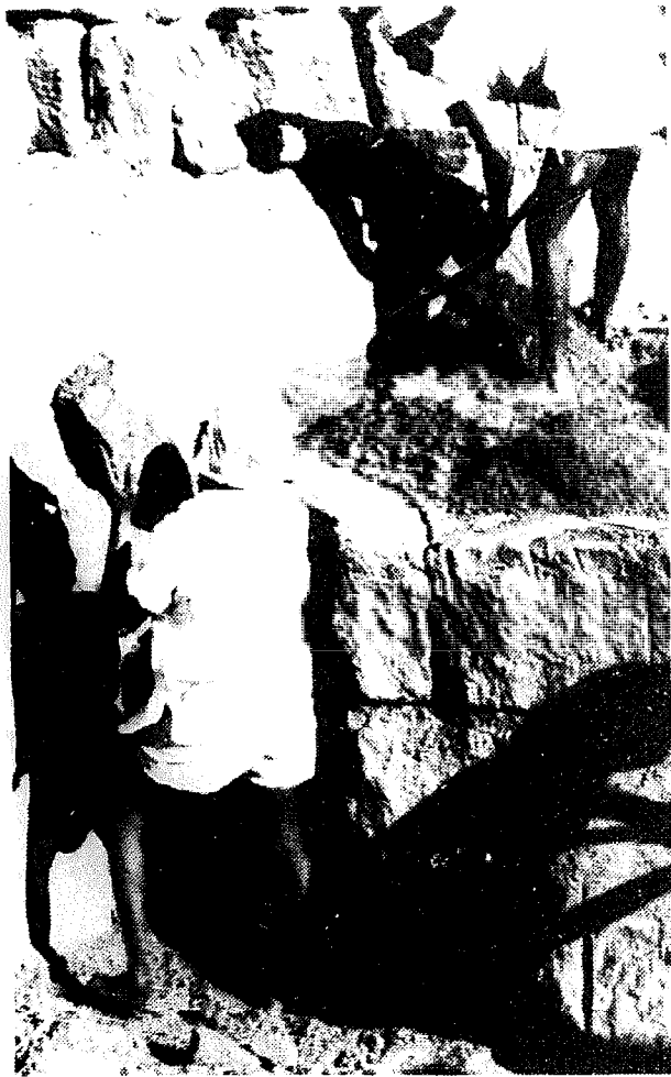
a. Digging clay
