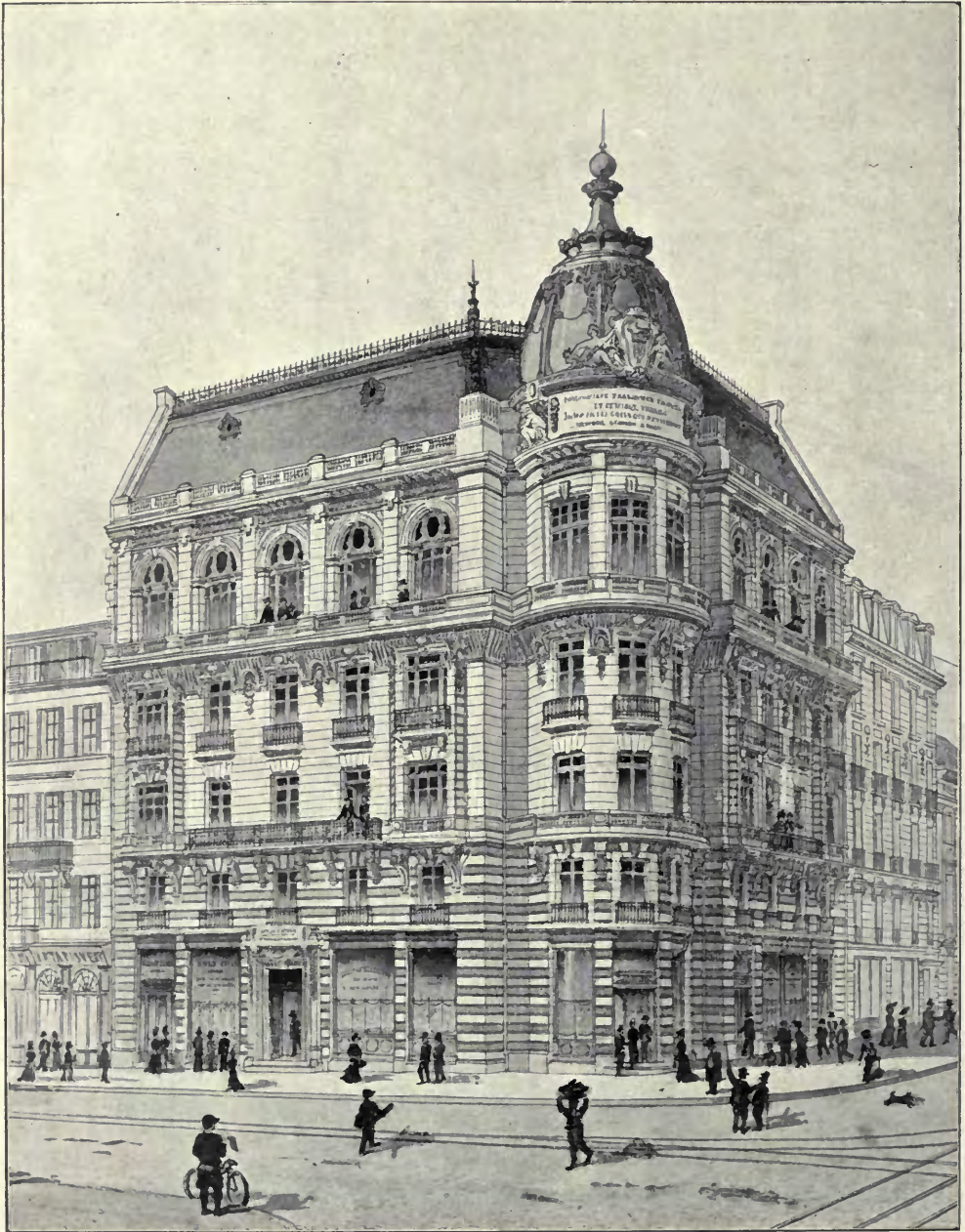
4056. Un hôtel pour des Sociétés d'Ingénieurs à St. Etienne, LÉON ET MARCEL LAMAIZIÈRE, Architectes. (Mention honorable.) (For Plans, see p. 73.)
