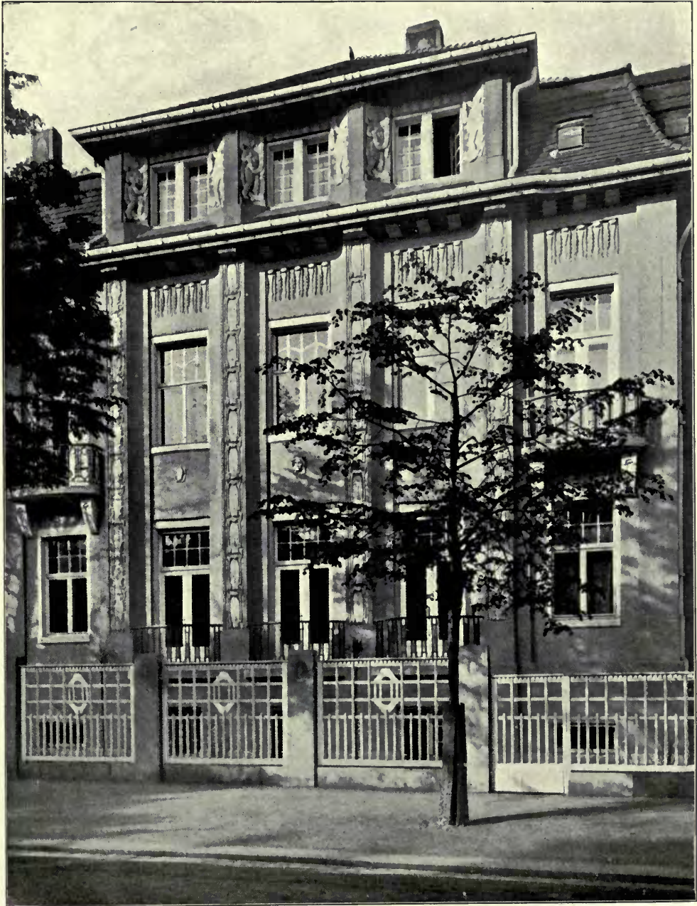
Haus Becker, Dresden, SCHILLING AND GRAEBNER, Architekten.
