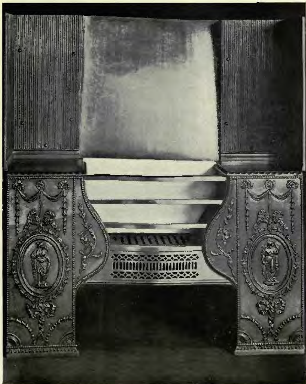
FIG. 227. CAST-IRON HOBGRATE.
