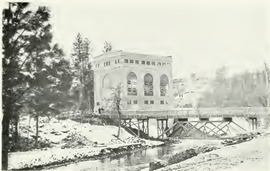
HAT CREEK POWER-HOUSE, No. 1
