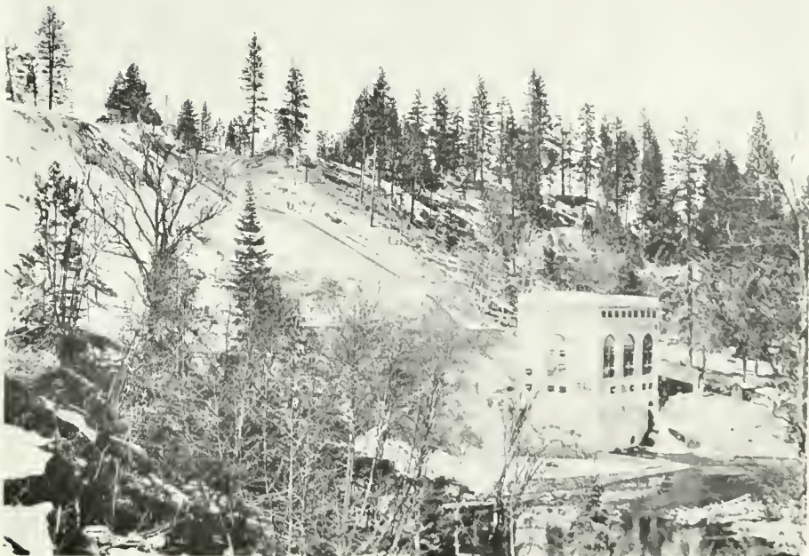
HAT CREEK POWER-HOUSE, No. 2
