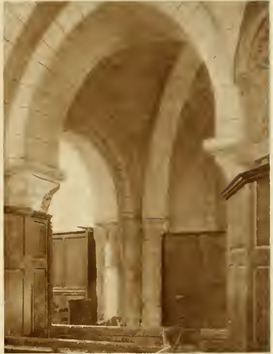
FIG. 14. St. - Pierre, Acy-en-Multien, (Oise). Vault beneath Tower.
