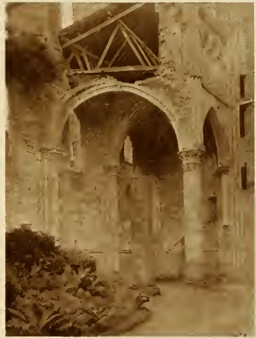
FIG. 30. Abbaye, Longpont, (Aisne). South side aisle.
