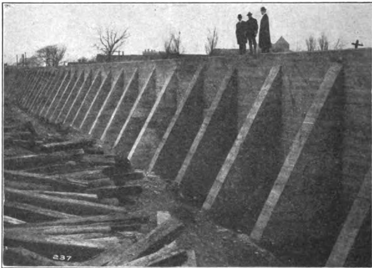
FIG. 40.—Buffalo retaining wall, D. L. & W. R. R.
