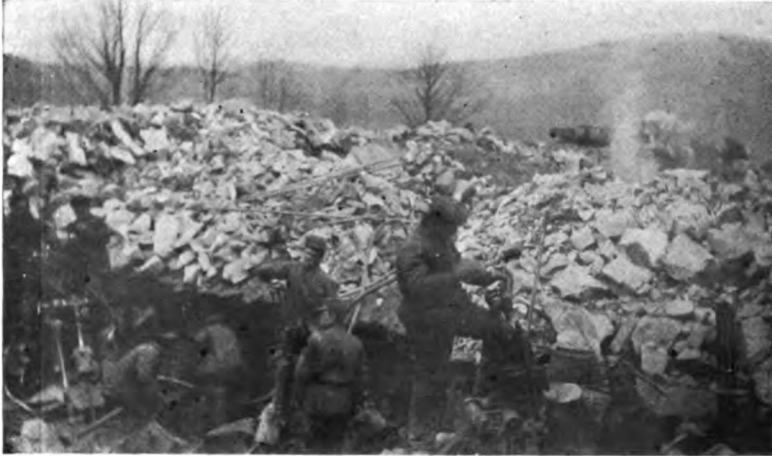
FIG. 51.—Drilling at Andover, N. J.
