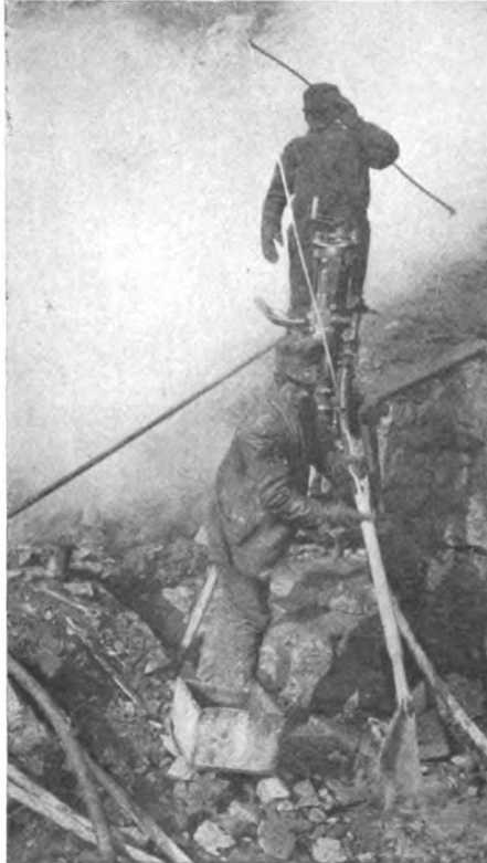
FIG. 66.—Bailing Holes.
