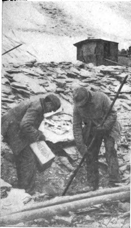
FIG. 57.—Charging Holes, Vail, N. J.
