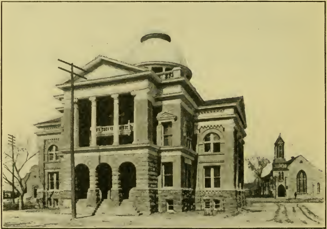
FIG. 117. CITY HALL, EL PASO
