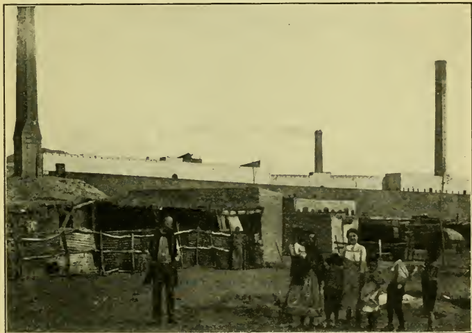
FIG. 118. AN EL PASO SMELTER
