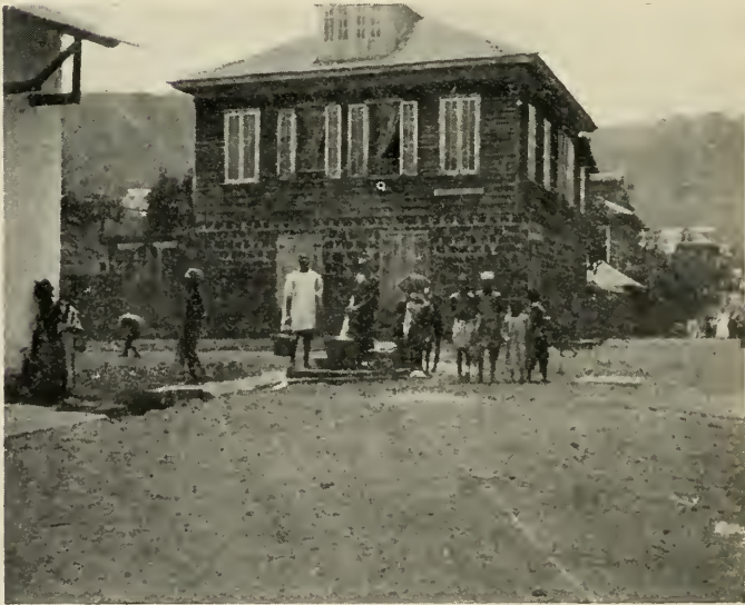
FIG. 45A.—Street Stand-Pipe in Actual Use.
