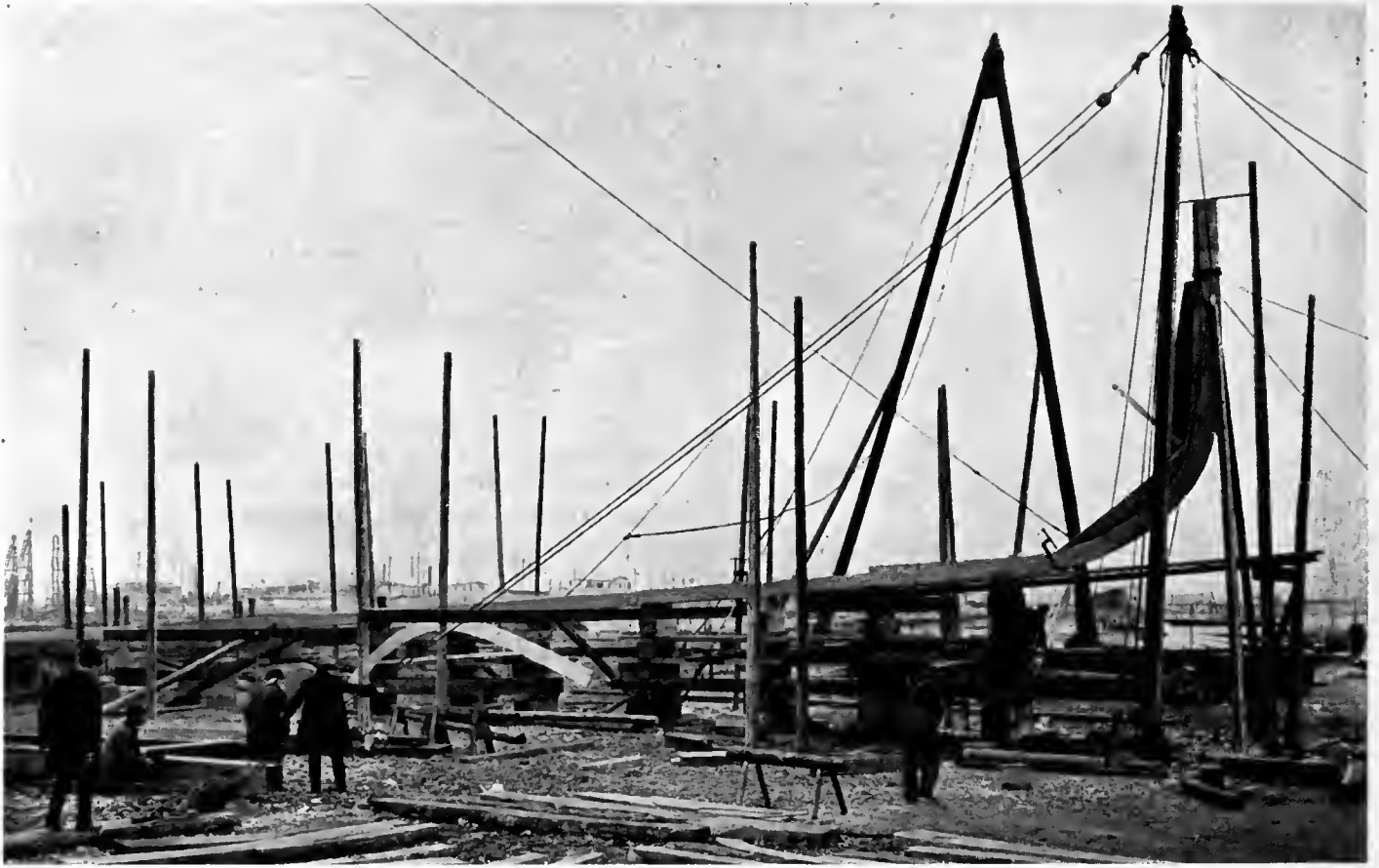
Fig. 30. Keel Set Up
