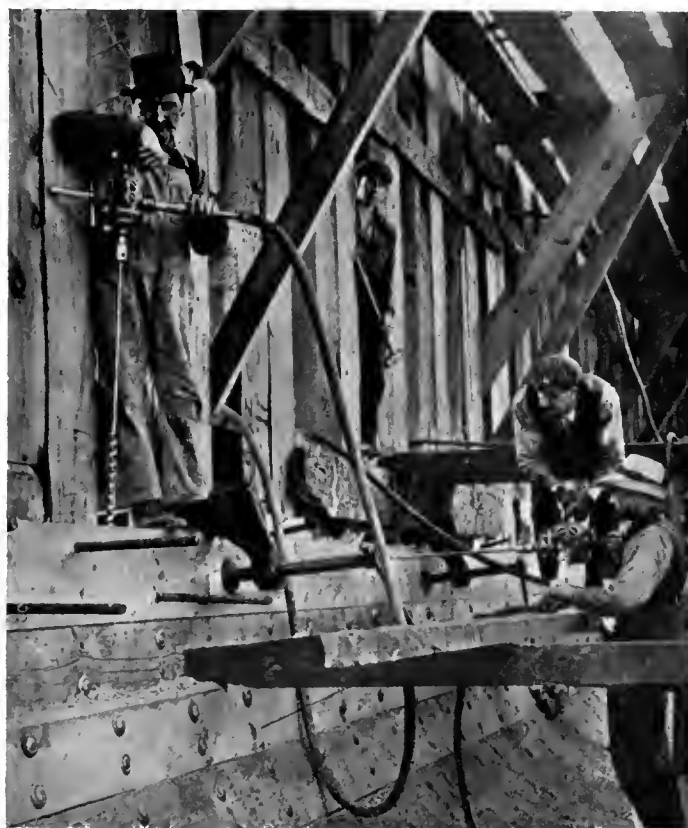
Fig. 43b. Edge Bolting Ceiling
