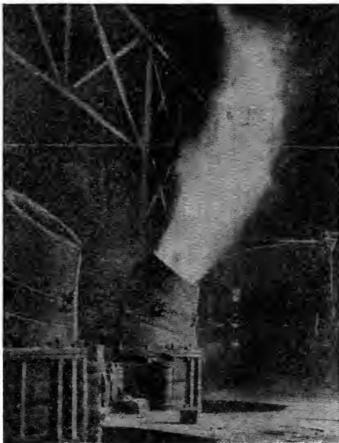
Fig. 9. Bessemer Converter.
