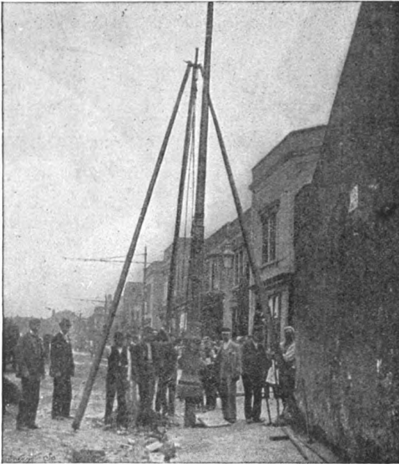
FIG. 88.— POLE DERRICK.
