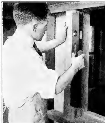
Fig. 112. Plumbing Frame
