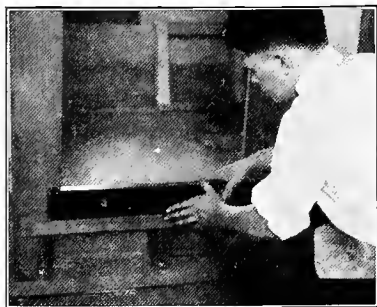
Fig. 111. Leveling Door Sill
