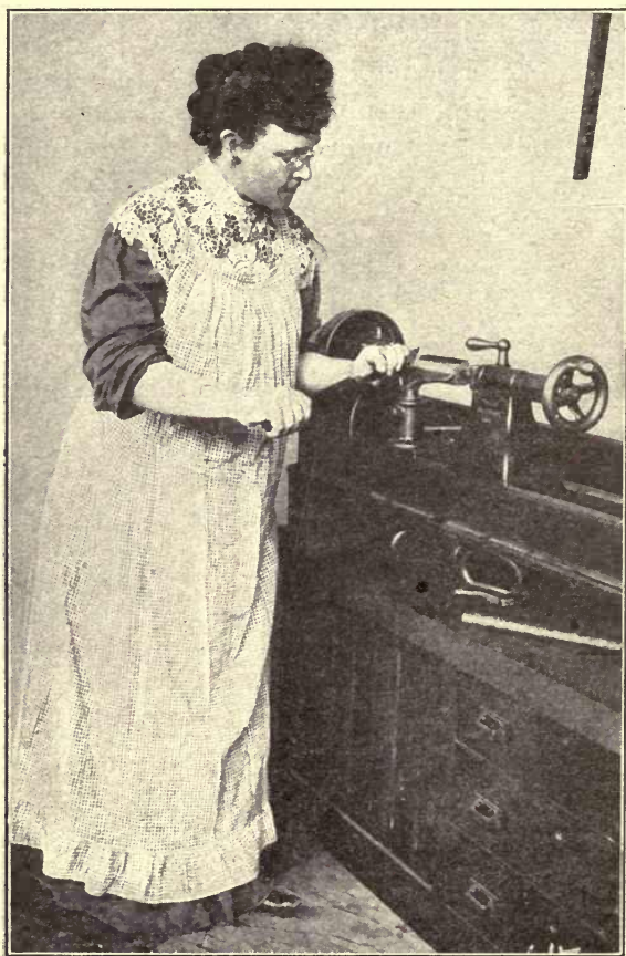
Fig. 29. Using the Skew Chisel.
