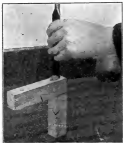
Fig. 84. Splitting a Tenon.
